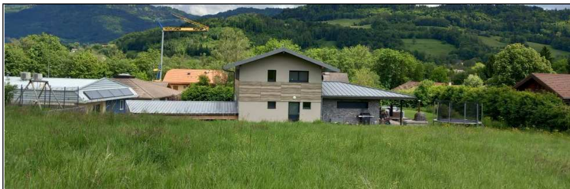
Exemple de constructions et aménagements faisant obstacle aux écoulements sur la totalité de la largeur du tènement
